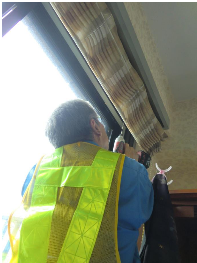
内窓外枠の取り付け
