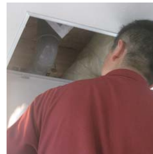
●点検口から天井裏を確認
