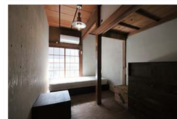
●歩き方ハウス 1階個室 以前の床の間と押し入れ部分を抜き、枠組みだけ残った面白い間取り。
