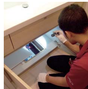
●キッチンの配管を確認
