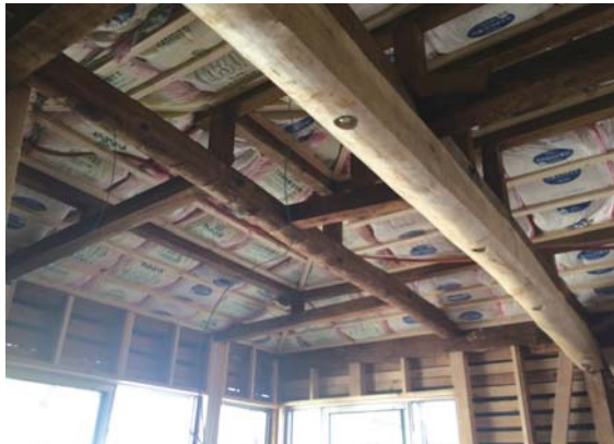
●断熱材施工状況参考写真(リビタ：「芦花公園の家」)
