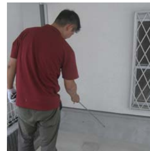
●打診棒で基礎コンクリートを確認
