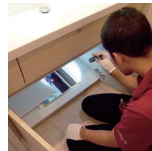
●キッチンの配管を確認
