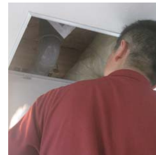
●点検口から天井裏を確認
