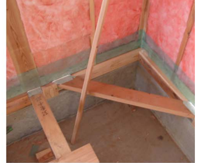
土台廻り気密シート先張り
