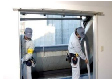
新規枠の取付け
