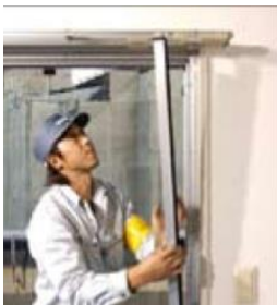
内部額縁の取付け
