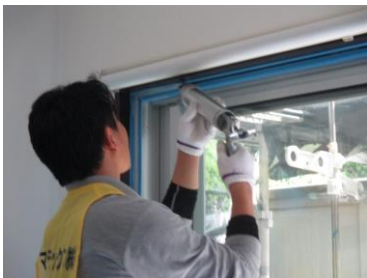
コーキング施工
