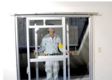
新しいサッシの取付け
