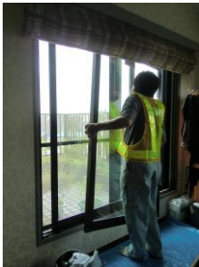
内窓のガラス障子の建て込み
