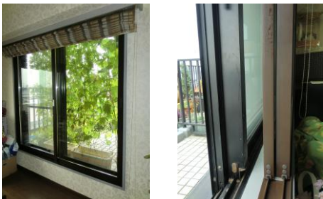
完成後の内窓
