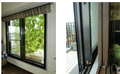
完成後の内窓
