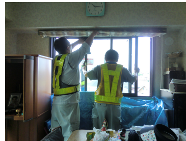
内窓のガラス障子の建て込み及び調整
