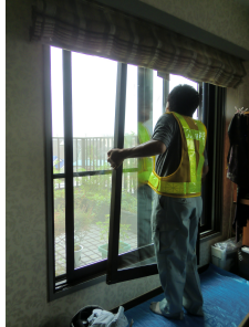
内窓のガラス障子の建て込み
