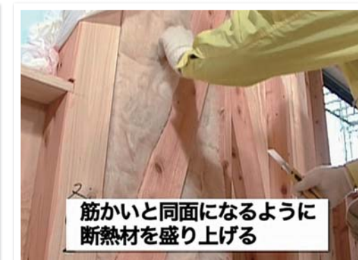
特に筋交いやコンセントBOXなど役物廻りにおいてはメーカーの施工要領内容の周知、実施、管理が大切。作業手間のかかる箇所なので、「とりあえず詰め込んである状態」をよとしていた現場管理が多いのが現状。
