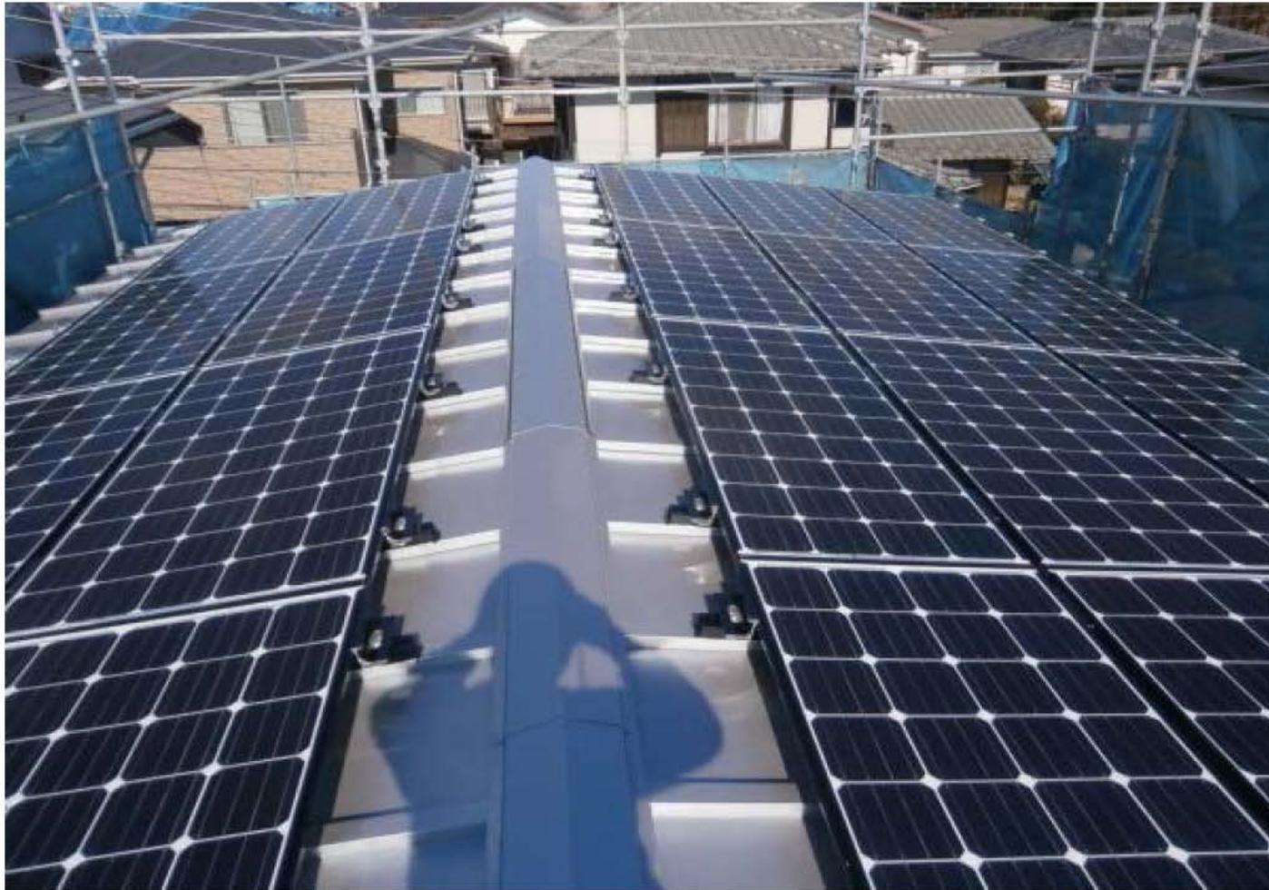
太陽光発電装置を設ける (出力 4.3KW)
